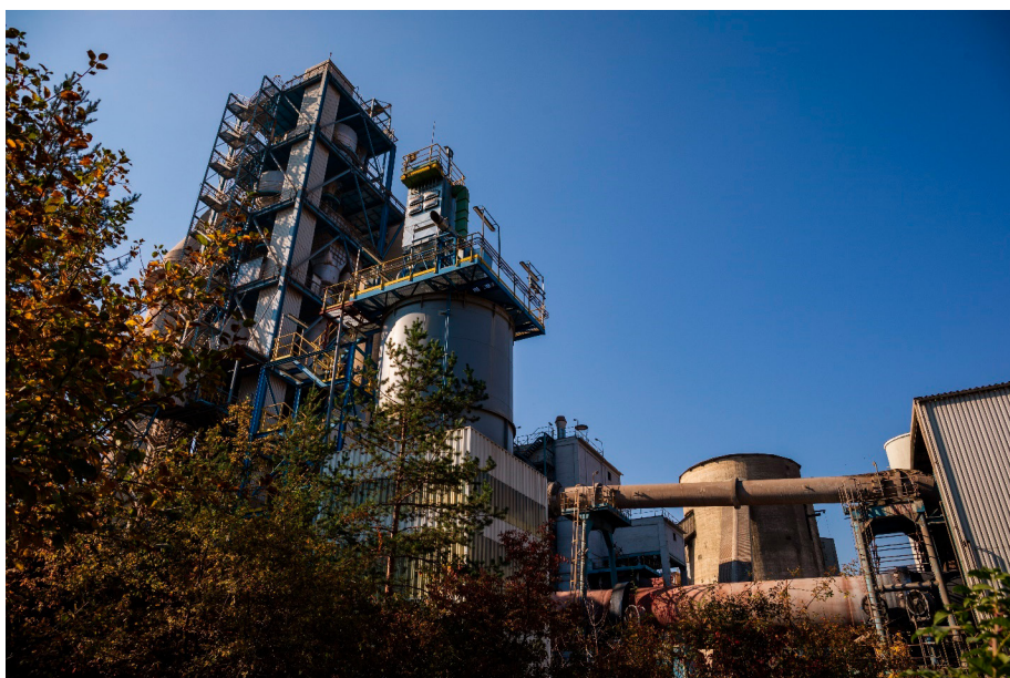
Zariadenie elektrofiltra a rotačnej pece
